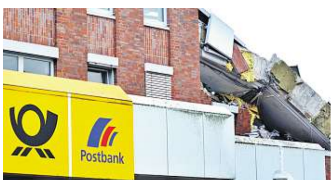
Das ehemalige Postgebäude an der Lübecker Straße in Bad Oldesloe wird zurzeit Stück für Stück abgetragen Finn Fischer
